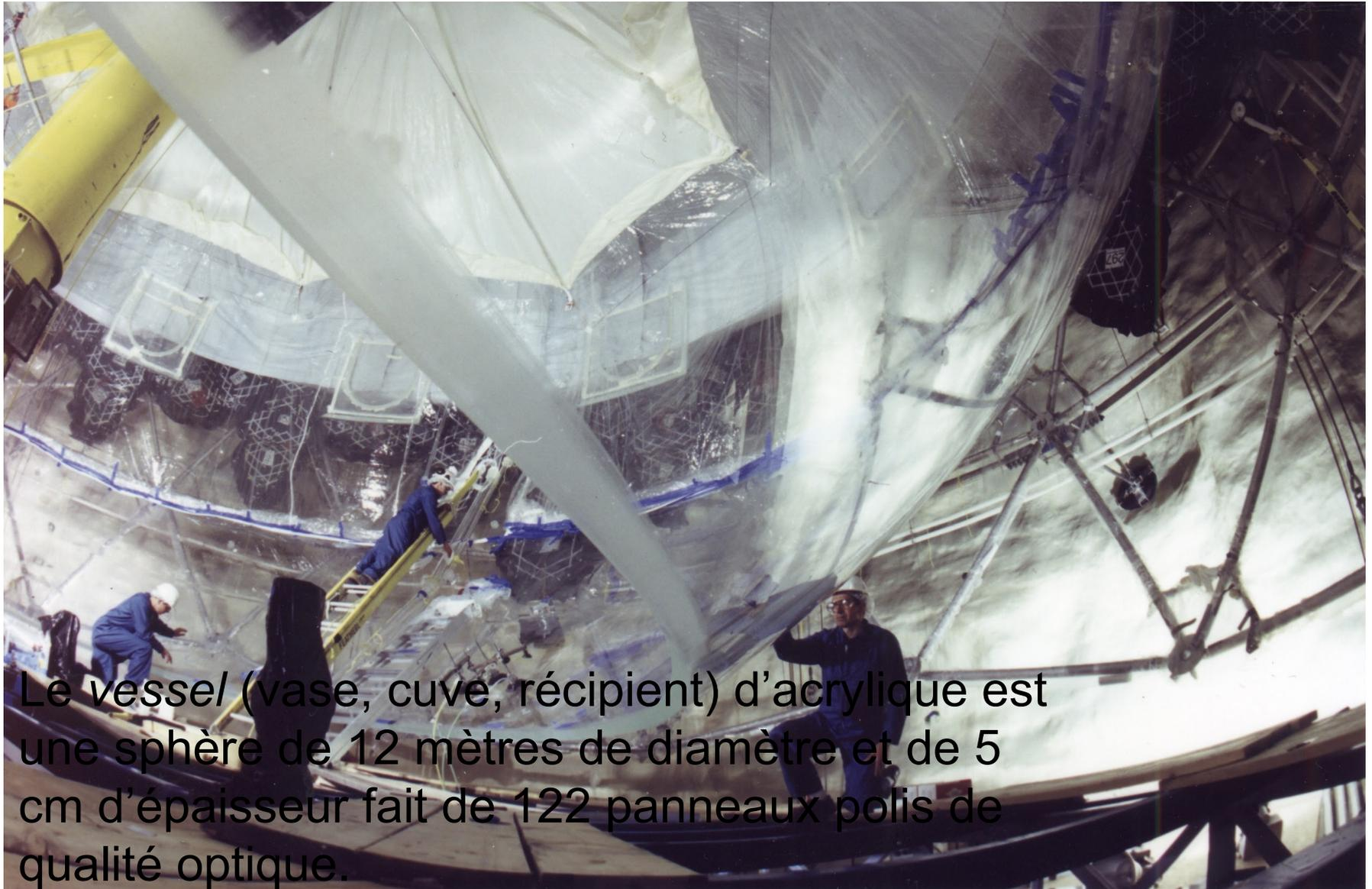
Le vessel (vase, cuve, récipient) d'acrylique est une sphère de 12 mètres de diamètre et de 5 cm d'épaisseur fait de 122 panneaux polis de qualité optique.
