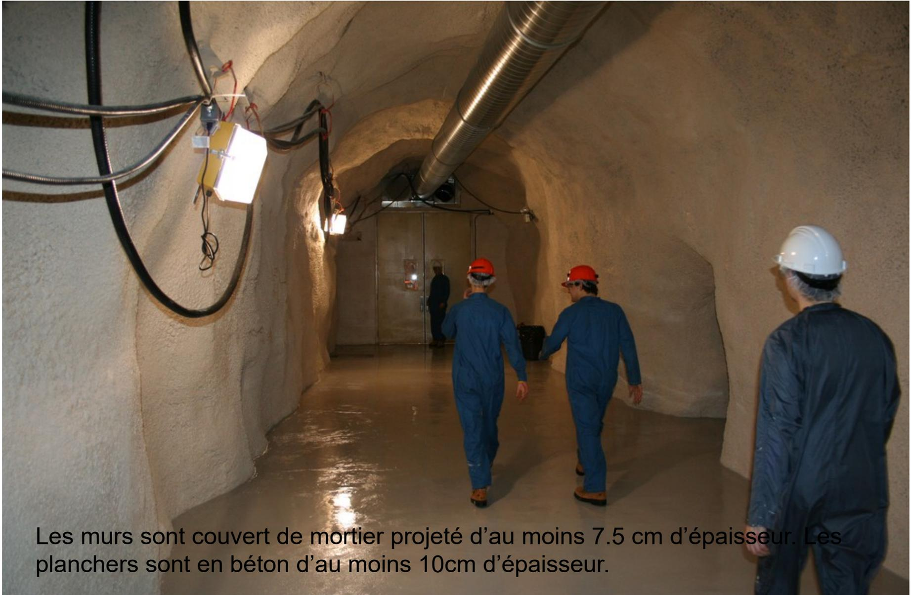
Les murs sont couverts de mortier projeté d'au moins 7.5 cm d'épaisseur. Les planchers sont en béton d'au moins 10cm d'épaisseur.
